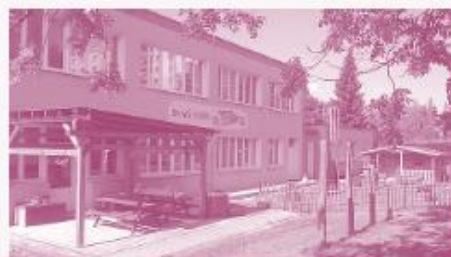
Pracoviště Staniční 72, Plzeň - Doubravka
