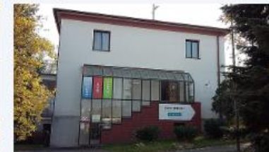
Pracoviště Ledecká 23, Plzeň - Bolevec
